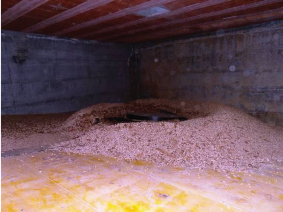
Silo a fondo inclinato con tramoggia presso l'azienda Borgna
