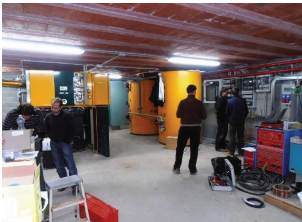
Installazione presso l'azienda Borgna e collegamenti con sistema di trasmissione dei dati a distanza.
