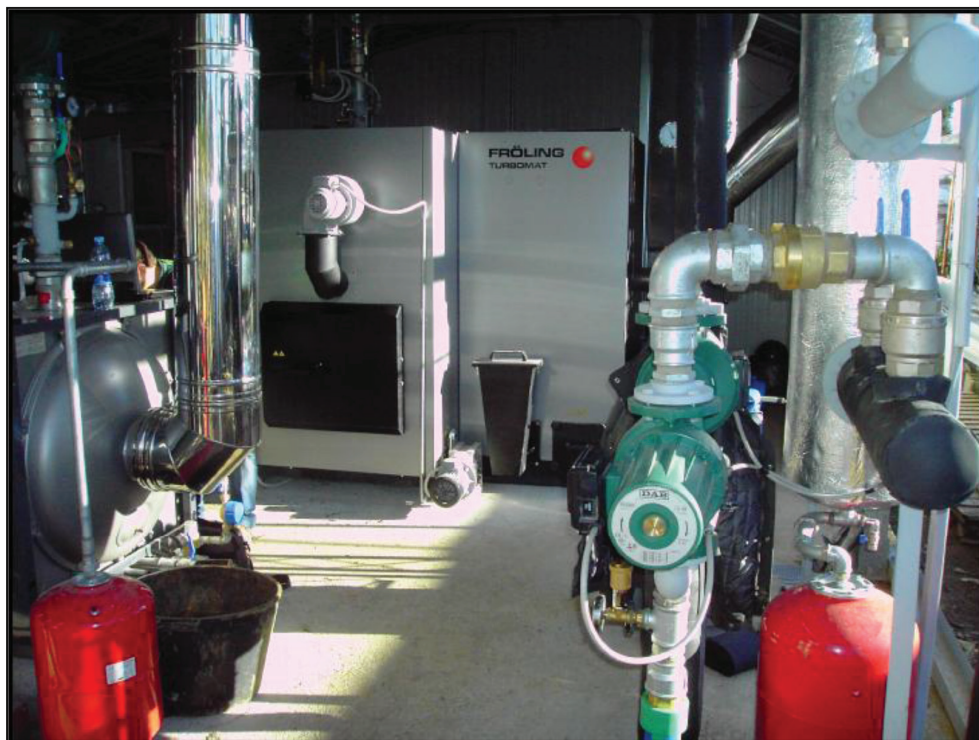
Impianto ultimato e funzionante dai primi mesi dell'anno 2011
